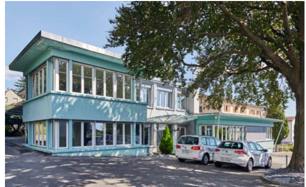
Atelier mécanique de Grenchen / Entrepôt
